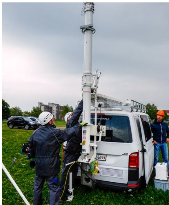
Tests haben bestätigt: Die Befestigung der 15 Meter hohen, hydraulisch ausfahrbaren Antennenmasten und die Stromversorgung und Klimatisierung funktionieren einwandfrei.
