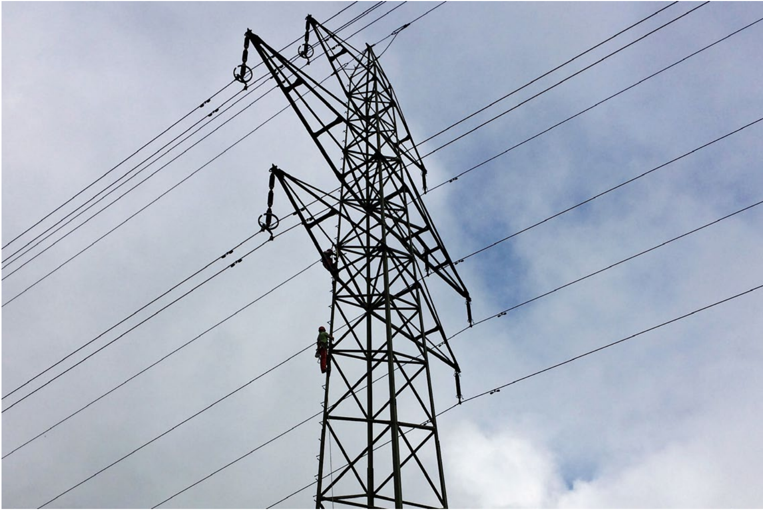
Freiluftmonteure ersetzen Isolatoren. Eine Arbeit, die Höhentauglichkeit und Klettererfahrung voraussetzt.
