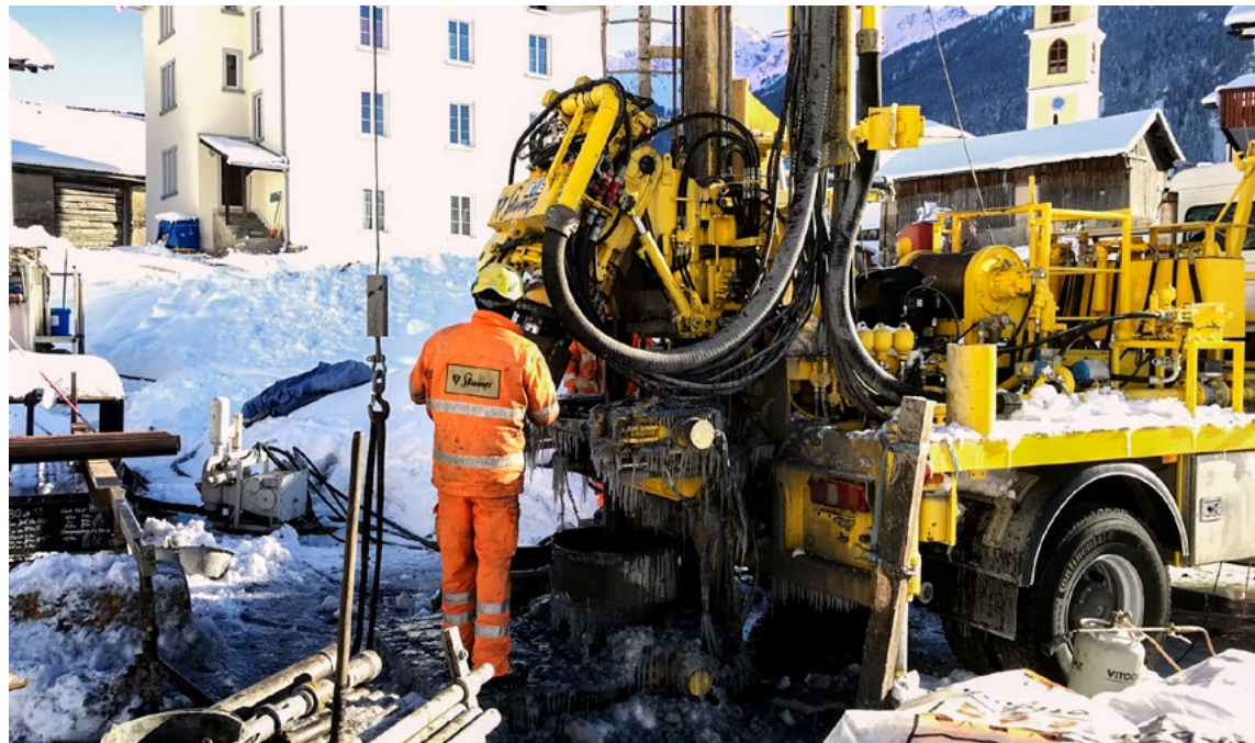
Kernbohrungen in Brienz/Brinzauls. Mit Hilfe von Bohrungen und seismischen und geoelektrischen Untersuchungen wird versucht, den Schichtverlauf im Untergrund zu verfolgen.
