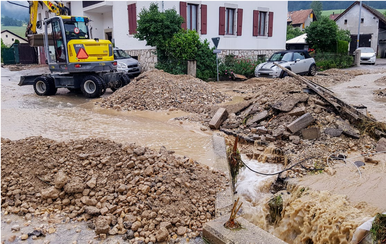
Bei Starkregen spielen Verkehrswege oft eine wichtige Rolle beim Abfluss der Wassermassen. Dies kann zu grossen Schäden an der Infrastruktur führen.
