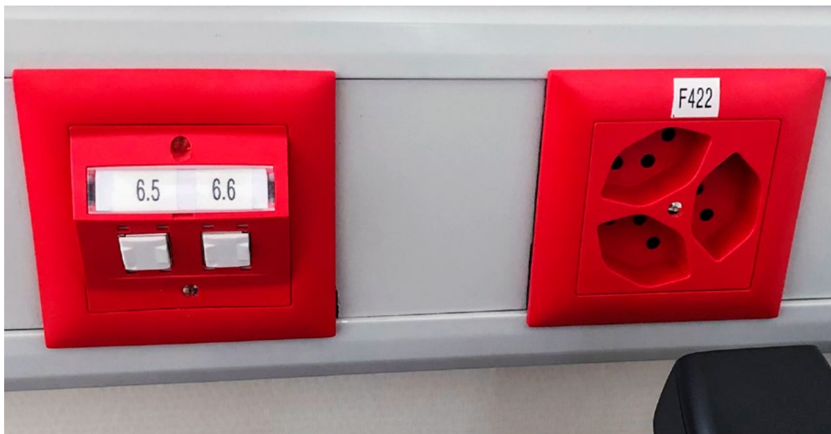
Jedes Gemeindehaus hat rote Notstrom-Anschlüsse für die notwendigen Endgeräte (Laptop, Drucker, Telefon, Leuchtmittel) erhalten.
