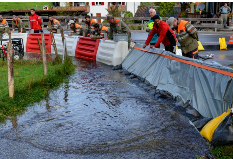
Der mobile Hochwasserschutz weist das Wasser ab: rechts die klassische Bauweise mit Paletten, Bauplastik und Sandsäcken, links rote und weisse, mit Wasser gefüllte Kunststoff-Dammelemente.
